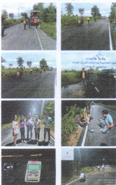
ภาพก่อนการดำเนินงานเสริมผิวถนน
