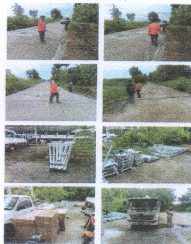
ภาพก่อนการดำเนินงานเสริมผิวถนน
